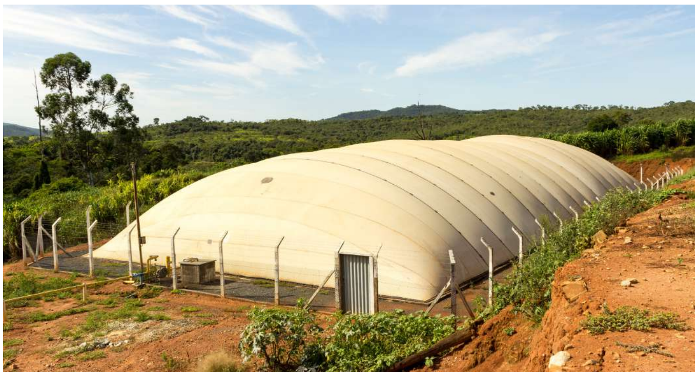
Biodigestor de dejetos animais para produção de biogás e biofertilizante.
