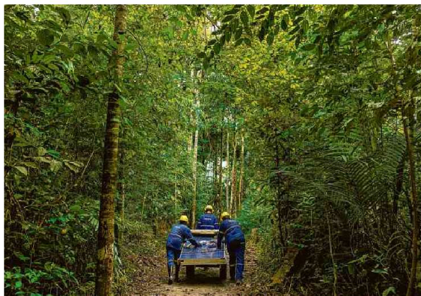
Operários levam placas solares por uma trilha na zona rural do município de Portel (PA)
