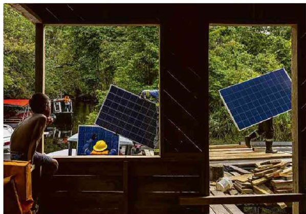
Funcionários descarregam placas fotovoltaicas em uma comunidade ribeirinha de Portel
