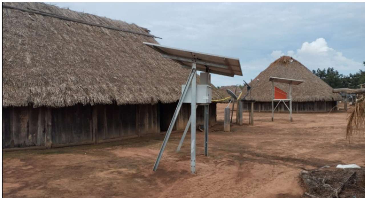
Figura 17. Instalação dos SIGFIs 80 nas residências da Aldeia Khikhatxi. FOTO: Vinícius Oliveira/IEMA
